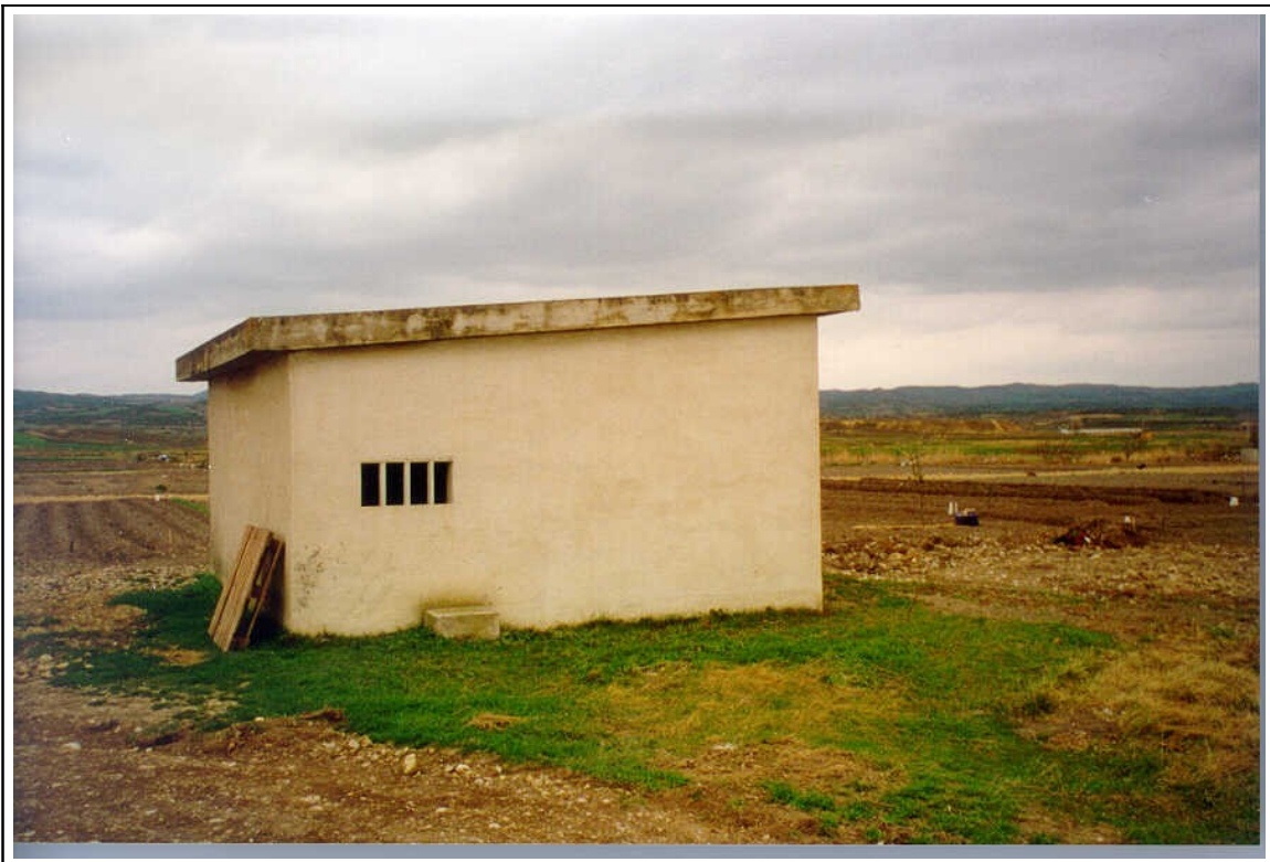
Caseta. Foto Intecsa (04/03/1999)
