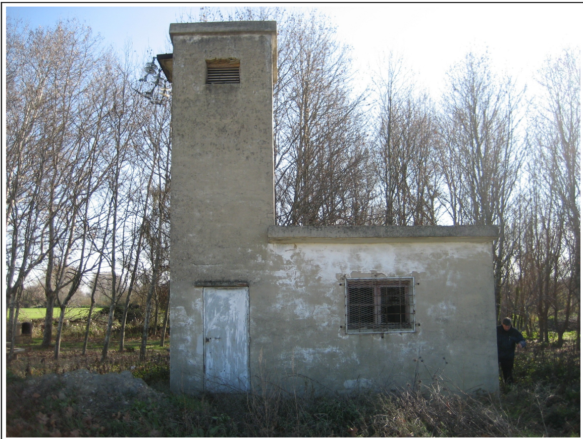
Edificio donde se encuentra el bombeo de Olite (20/12/2006)
