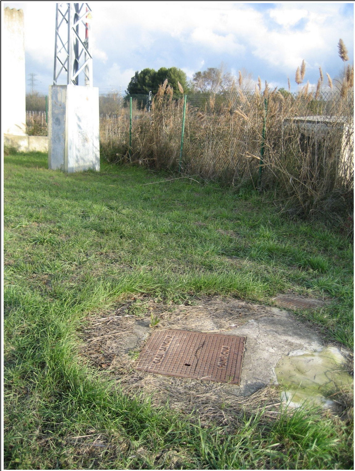
Alcantarilla del pozo Orzanco (20/12/2006)
