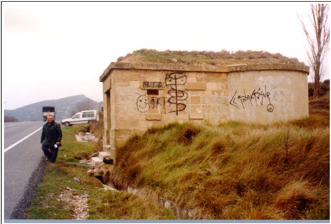
Caseta de captación. Toto Intecsa (02/03/1999)
