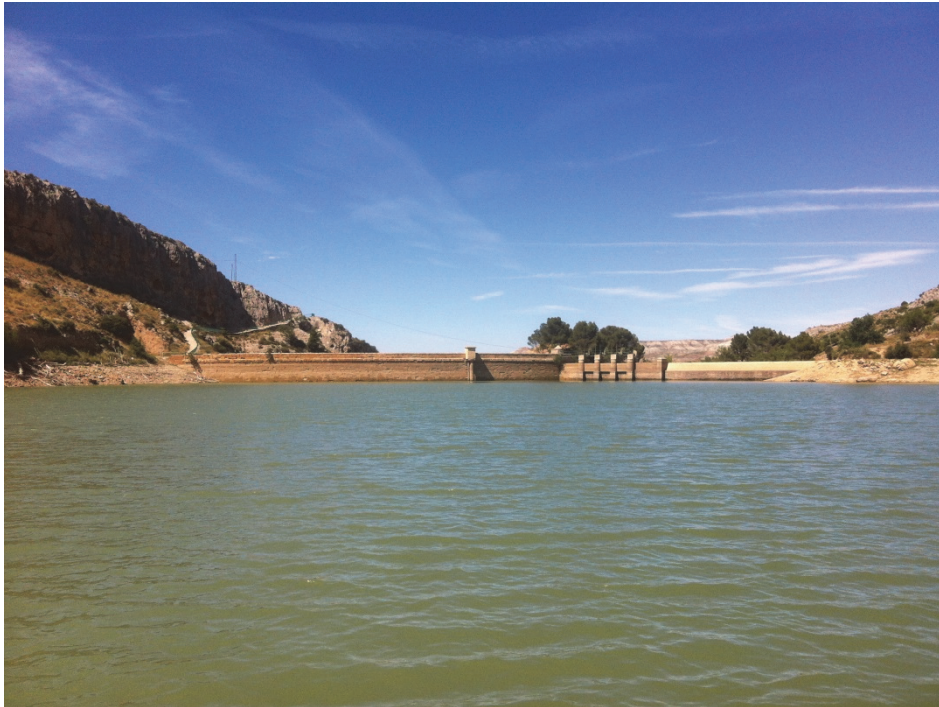
Figura 7. Vista de la presa del embalse
