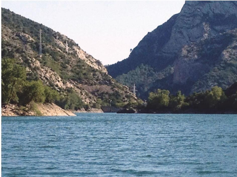
Figura 7. Vista de la presa del embalse
