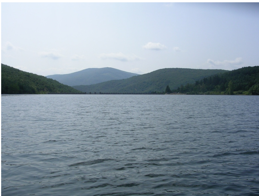
Figura 7. Vista de la presa del embalse
