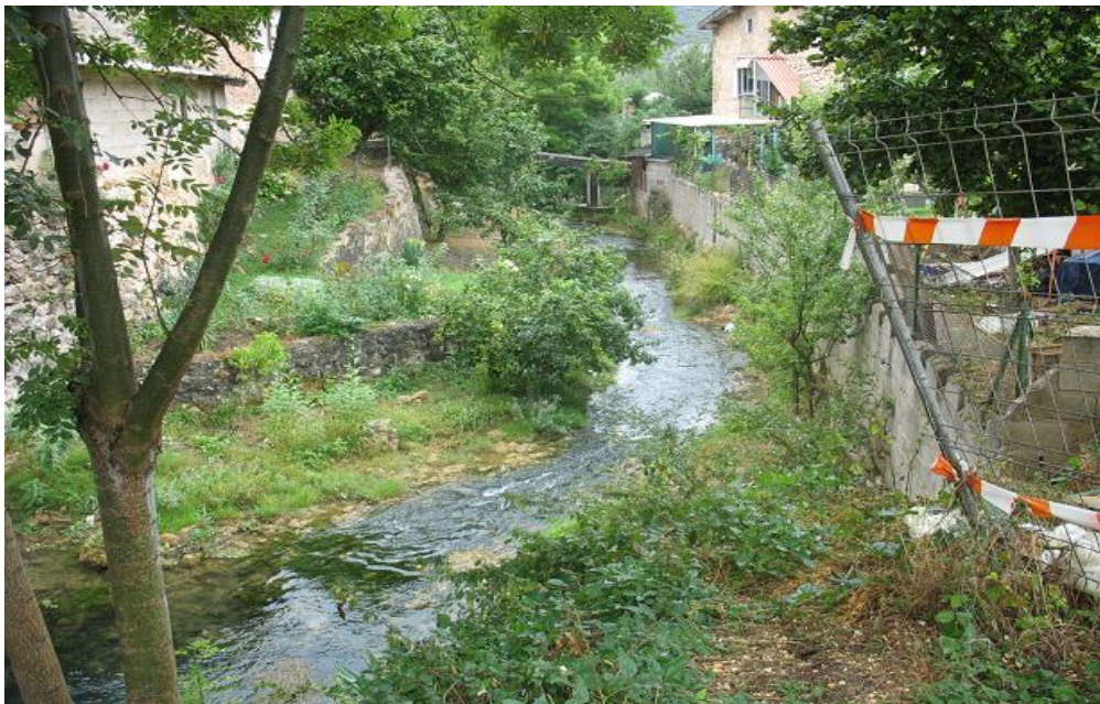
Figura 16-5. Cauce del río Inglares con defensas laterales.
