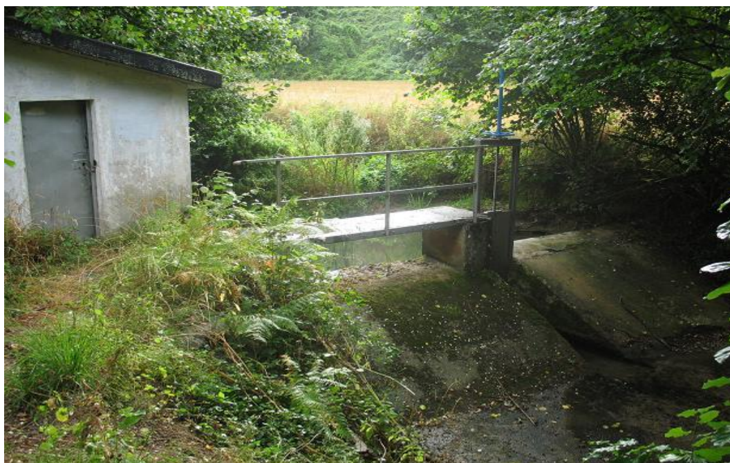
Figura 16-4. Azud de derivación.
