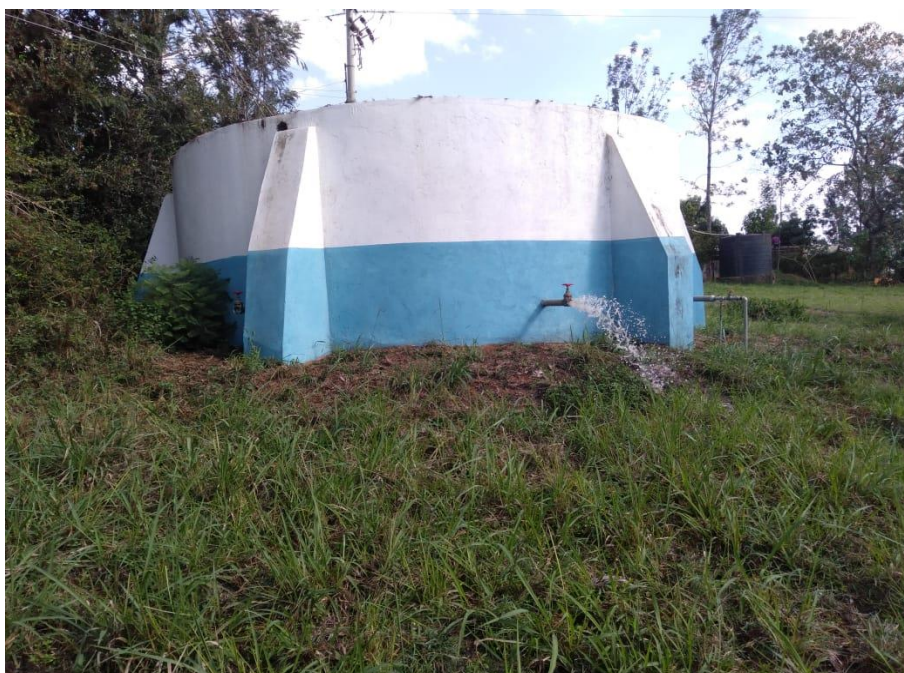
Imagen del depósito ya terminado
