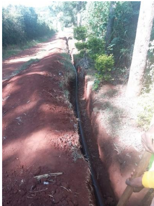
Imágenes avanzo las zanjas e instalando la tubería principal
