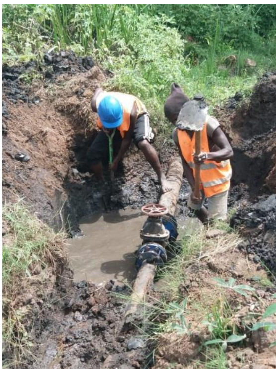
Imágenes avanzo las zanjas e instalando la tubería principal
