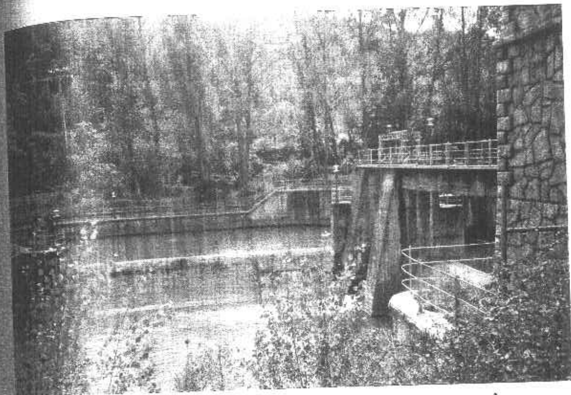
Presas y chopera en margen derecha de la presa, aguas abajo de Noales.
