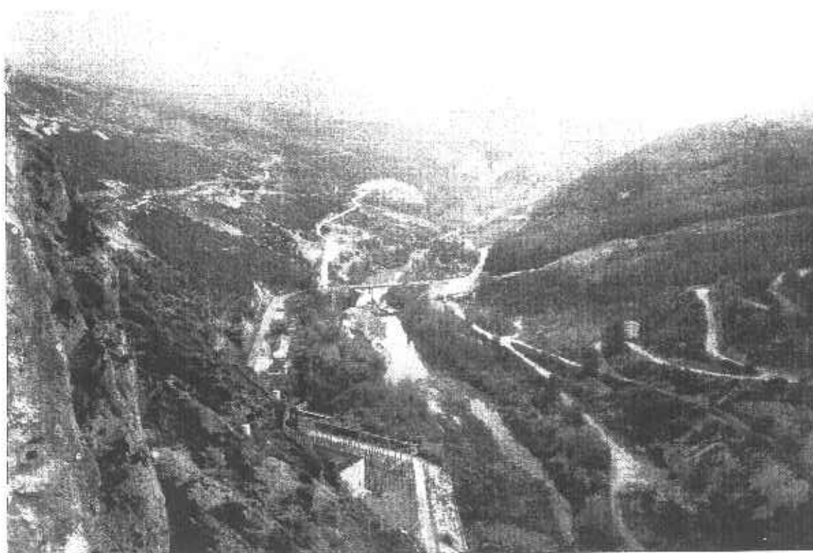
Río Noguera Ribagorzana aguas abajo de la Presa de Canelles y Central eléctrica.
