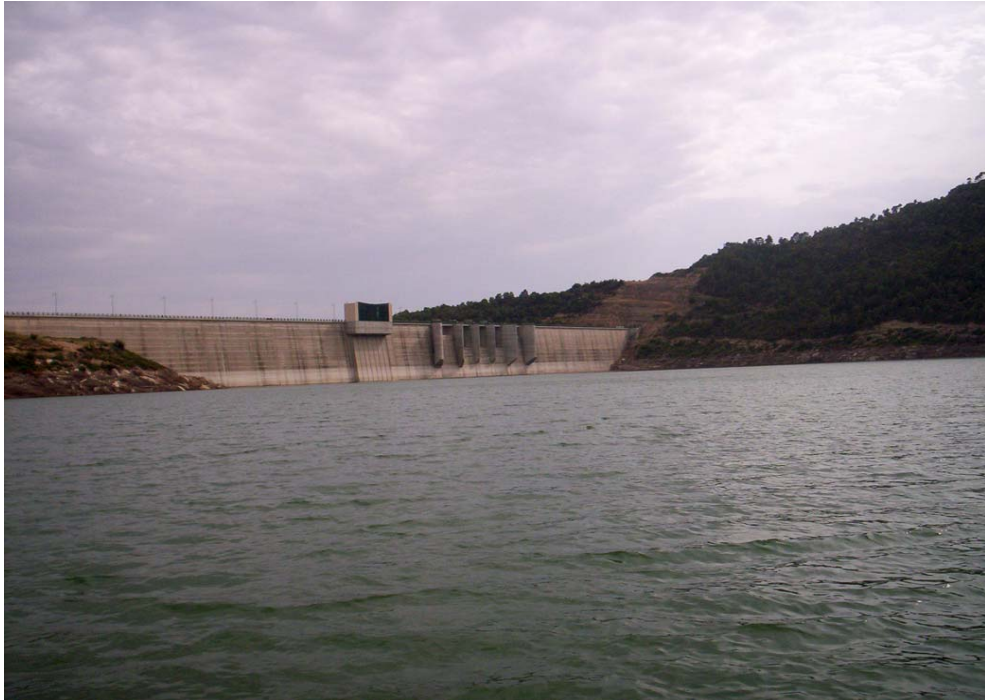
Vista de la presa desde la estación de muestreo (E1). Verano de 2004 (03/08/2004)
