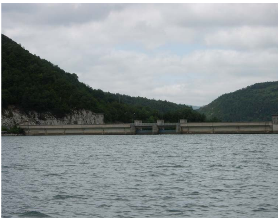
Vista de la presa desde la estación de muestreo (E1). Verano de 2005 (07/07/2005)
