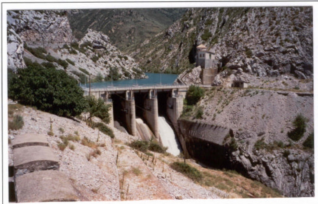
Presa de Sopeira situada a 1,5 km aguas abajo de la presa de Ecales.
